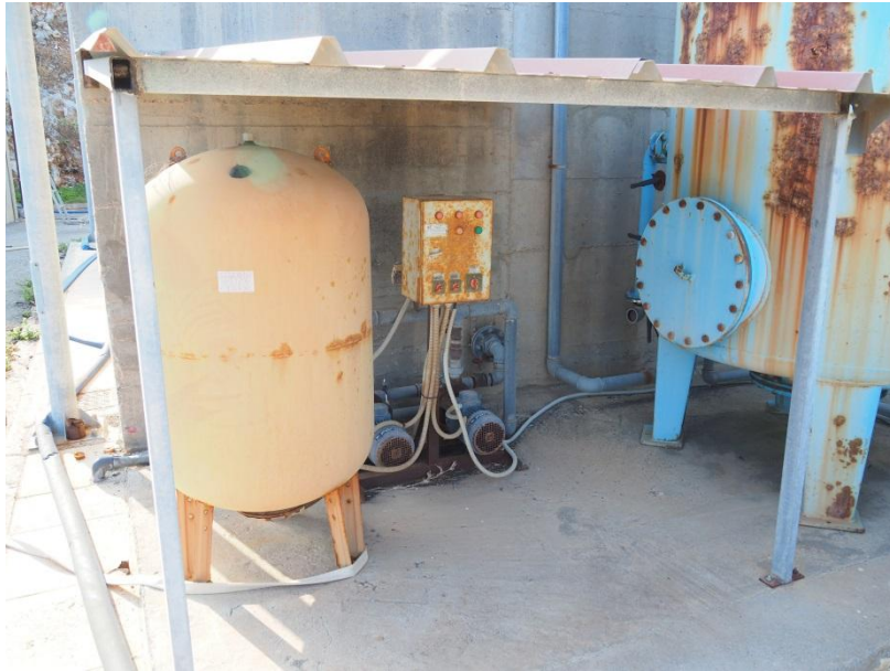
Εικόνα 16 Φίλτρο διύλισης & αντλίες βιομηχανικού νερού
