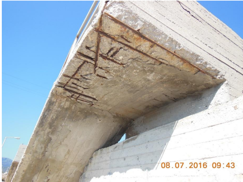
Εικόνα 12 Αποκάλυψη οπλισμού
