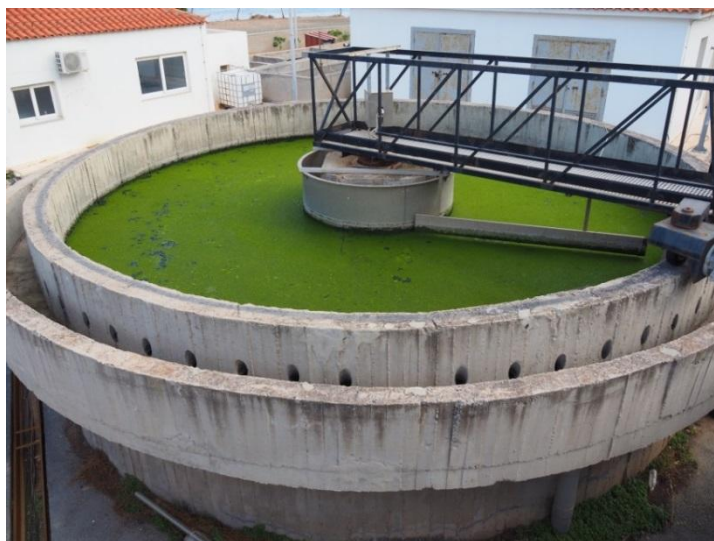
Εικόνα 13 Παλιά δεξαμενή καθίζησης
