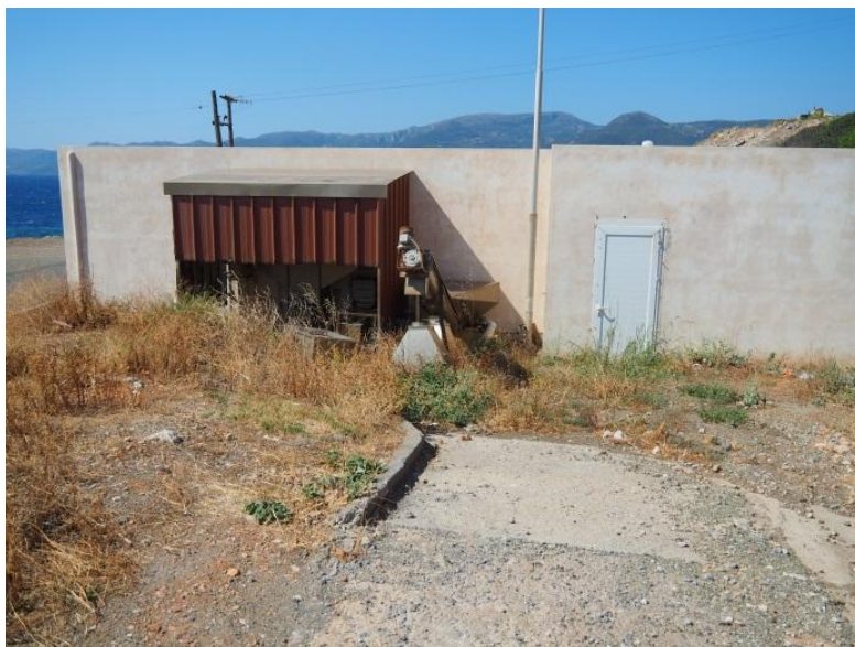
Εικόνα 6 Υφιστάμενος χώρος εγκατάστασης συστήματος απόσμησης
