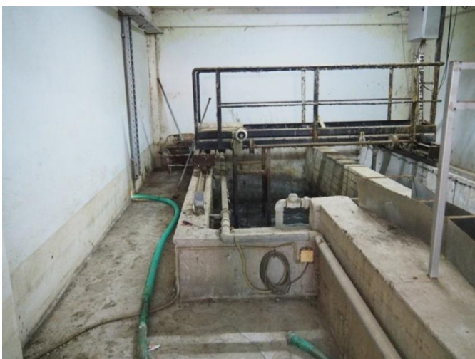
Εικόνα 4 Υφιστάμενη παλινδρομική γέφυρα εξάμμωσης - απολίπανσης
