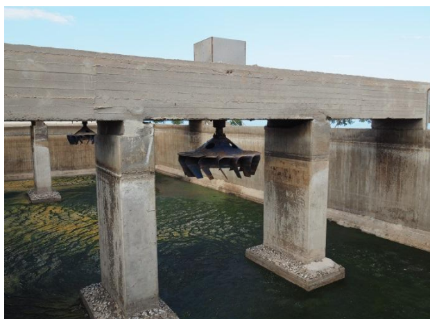
Εικόνα 8 Αεριστήρας παλιάς δεξαμενής αερισμού
