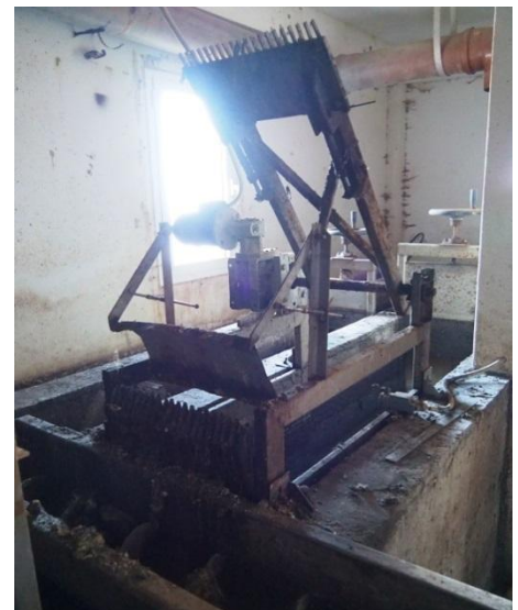
Εικόνα 3 Υφιστάμενη τοξωτή εσχάρα
