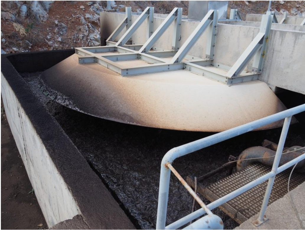
Εικόνα 9 Σκέπαστρο αεριστήρων νέας δεξαμενής αερισμού
