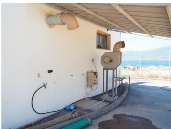
Εικόνα 2 Υφιστάμενος χώρος εγκατάστασης συστήματος απόσμησης
