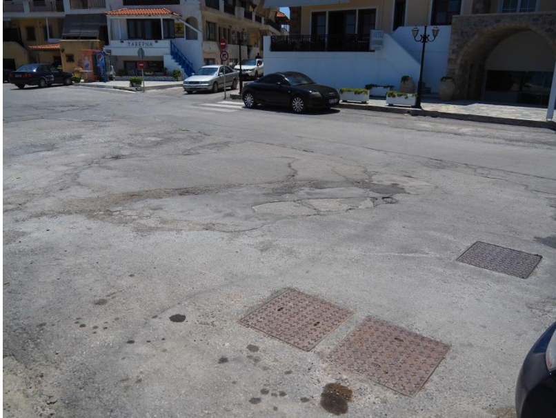
Εικόνα 19 Αντλιοστάσιο Hotel Filoxenia (Α/Σ-1)
